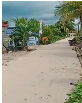
Jalan lingkungan yang telah dilakukan semenisasi dengan lebar 3 meter.
