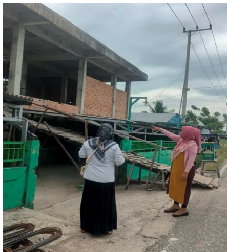
Masjid Al Fatah RT.7 dalam proses renovasi.
