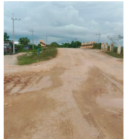
Jembatan Permanen RT.11 kondisi baik, batas antara wilayah RT. 11 dengan RT. 10.
