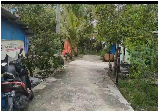
Jalan lingkungan yang telah dilakukan semenisasi dengan lebar 2,5 meter.
