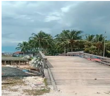
Jembatan Kayu RT.11 kondisi baik dan layak untuk difungsikan.
