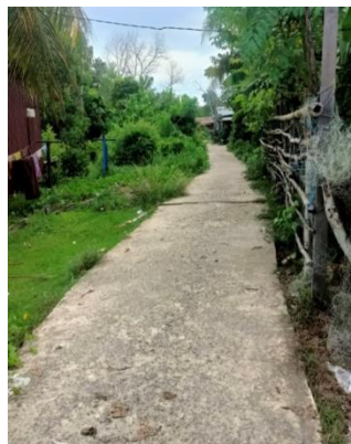
Jalan lingkungan yang telah dilakukan semenisasi di Gg. Raflesia RT.7.
